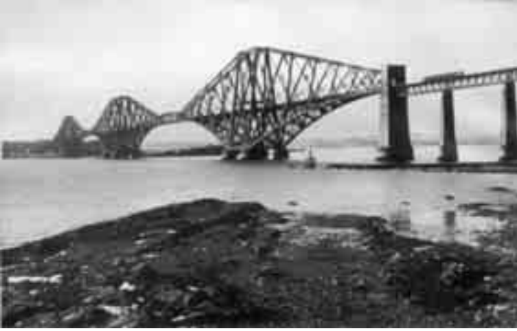
9 - الجسر الرابع. صممه سير جون فولر وسير بنيامين بيكر. جرى الاحتفال المئوي بإنشائه العام 1990. من أول الجسور التي استخدمت الفولاذ كمادة أساسية لبناء هيكلها.
